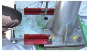
既設アンカーボルト撤去
