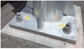
既設アンカーボルト
