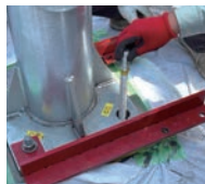
新規アンカーボルト設置
